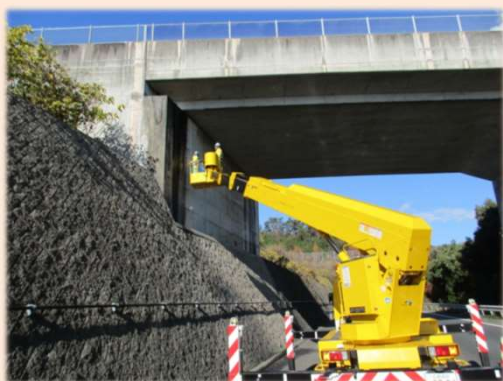
跨道橋の点検状況
