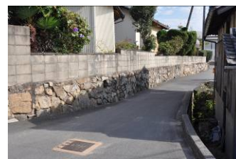
既成市街地内の狭あい箇所
