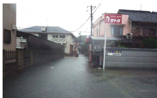
台風時の道路冠水の様子 (平成23年9月(台風12号))
