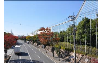
コンベックス岡山と (都)大内田鳥羽線
