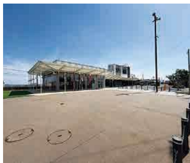
北側屋外交流広場
