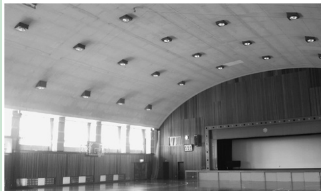
整備予定の中学校体育館吊り天井
