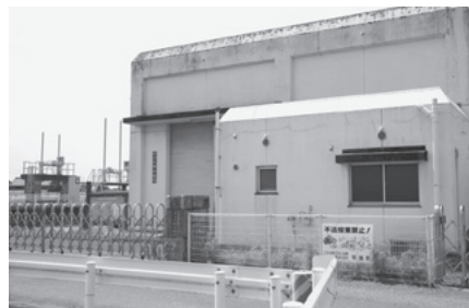
弁才天ポンプ場
