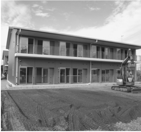
建設中の町営住宅
