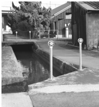
西コミ転落防止柵の設置状況
