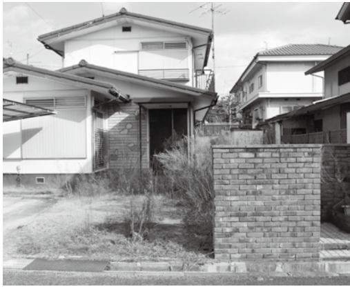
長年放置されている空き家
