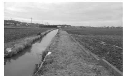
下前湯付近の田園及び水路状況
