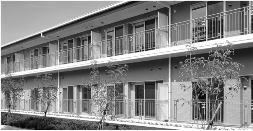
着々と建設がすすむ町営住宅噂島団地
