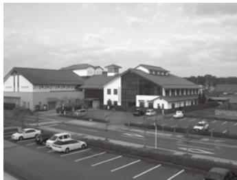
起債償還も完了した「ゆるびの舎」
