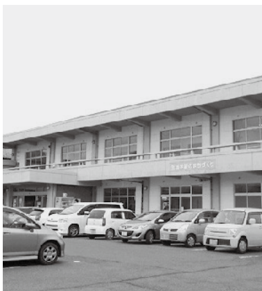
甚だしく老朽化した早鳥町中央公民館
