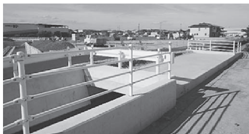
町道1号線 三番川函渠工部
