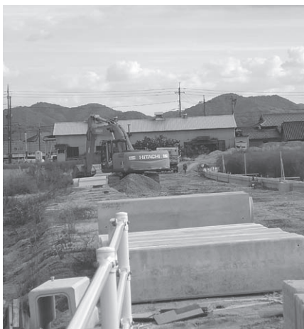
町道1号線の工事現場
