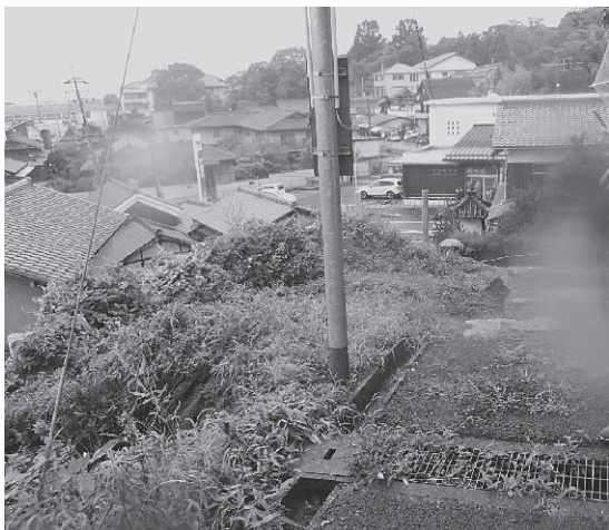
令和5年7月土砂災害発生現場(市場地内)
