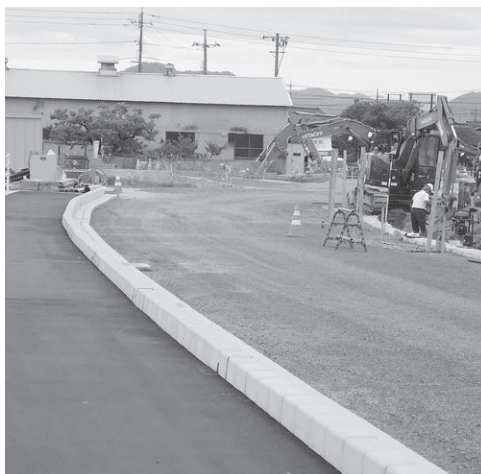
町道1号線の整備状況
