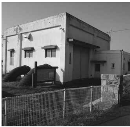
整備が待たれる排水機場
