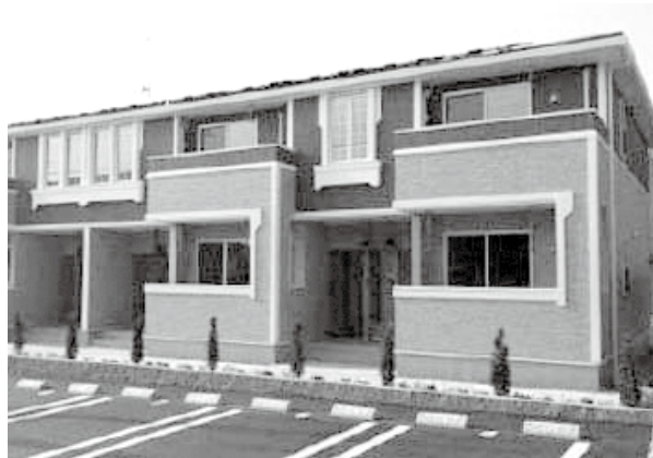
着々と建て替え工事の進む町営住宅
