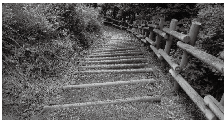
ふれあいの森公園 階段の一部
