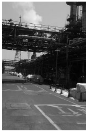
JX日鉱日石エネルギー麻里布製油所内
