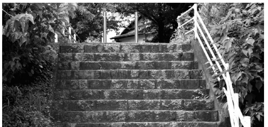
早島小学校西の町道
