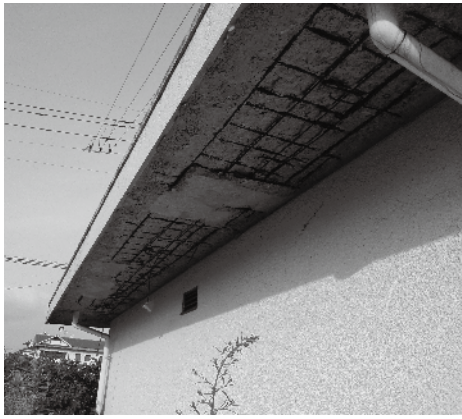
改修が待たれる倉庫
