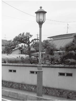
破損した街路灯と同型
