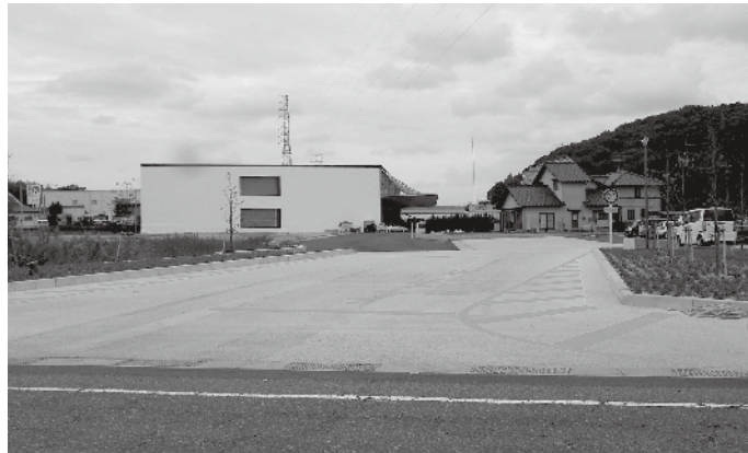
10月より稼働する大和ハウス物流倉庫
