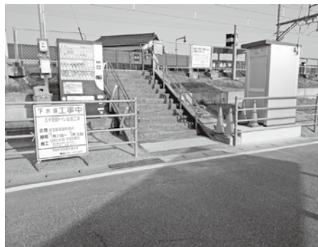
4月から供用開始予定の久々原駅のトイレ
