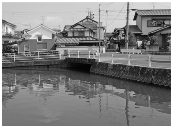
新しい樋門設置予定地
