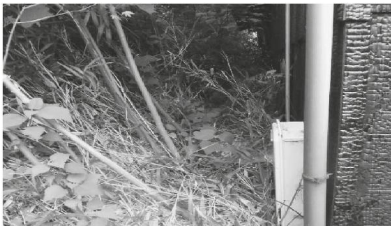
早島町で初めて避難指示が出た土砂崩落現場写真
