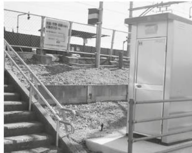
久々原駅トイレ整備事業243万5000円
