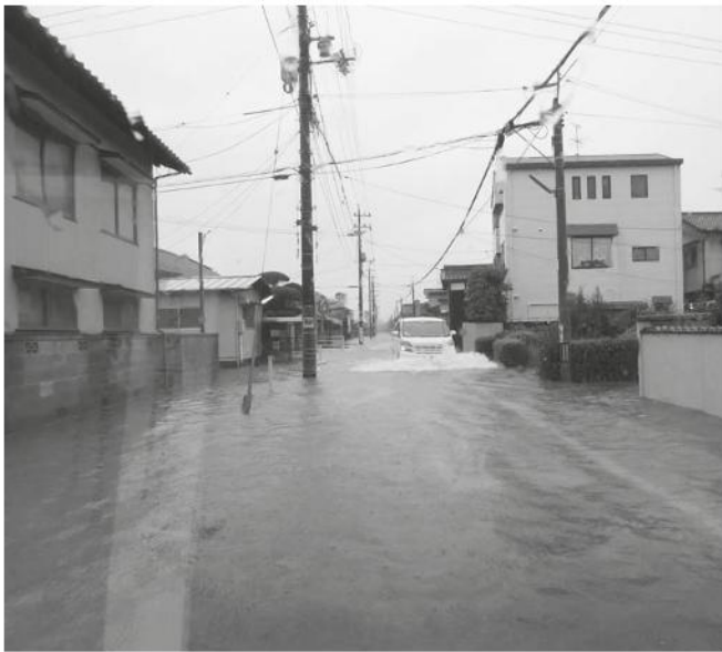
浸水被害が進む早島町内 (2018年7月)
