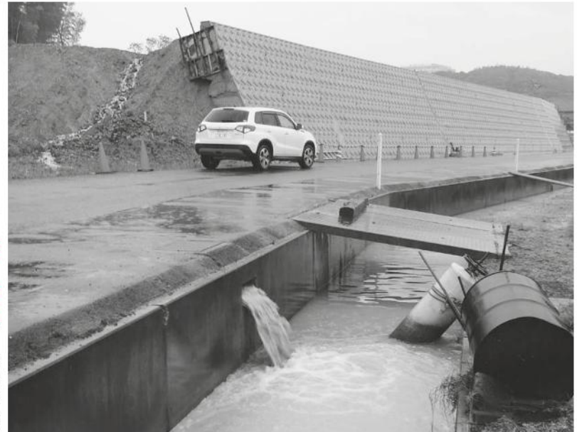
煙岡山開発地から用水路に土砂流出
