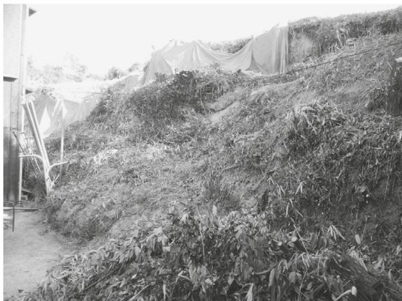
土砂が流れこんだ現場
