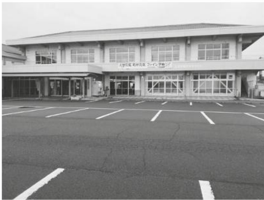
建設から約50年が経過し、検討が進められている。
