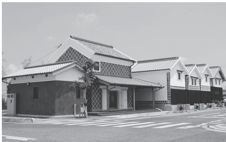
古民家再生により建てられた「早島町観光センター」
