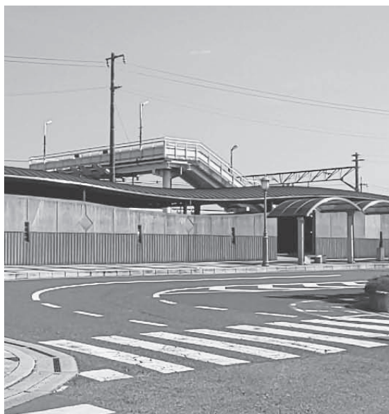
JR早島駅の跨線人道橋
