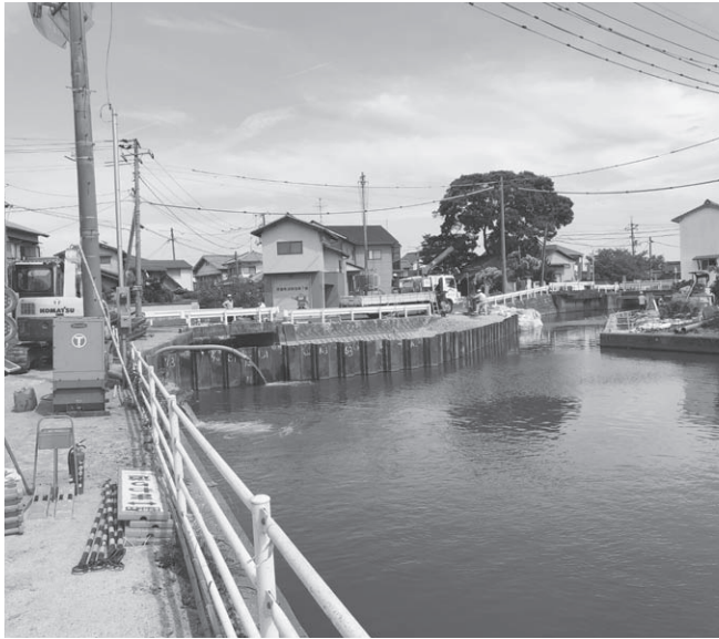
大川樋門の工事風景
