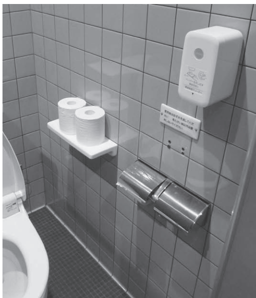
便座除菌クリーナーの設置してあるトイレ
