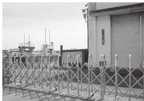
弁才天排水機場
