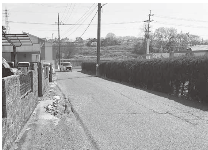
「老朽化が著しい県道から官舎への進入道路」
