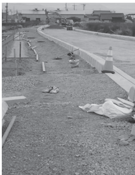
町道一号線の現状
