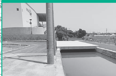
町道1号線道路改良工事
