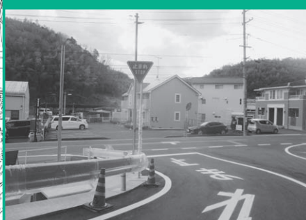
町道328号線交差点改良工事(日笠山)
