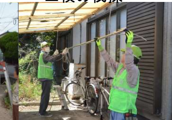
▲洗濯竿の設置
