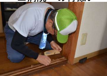
▲引き戸の修理
