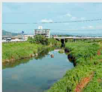
かつての撫川大橋橋脚跡
