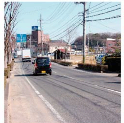
県道早島松島線4車線化事業に着手
