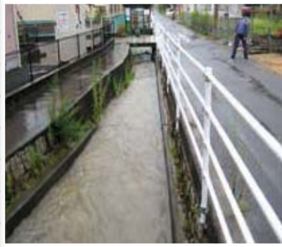
▲【矢尾地内】転落防止柵設置
