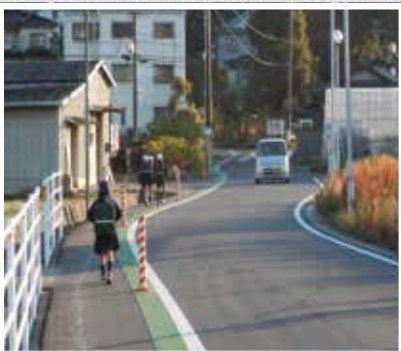
▲【大池・中山地内】転落防止柵設置 路肩カラー舗装・ポストコーン設置
