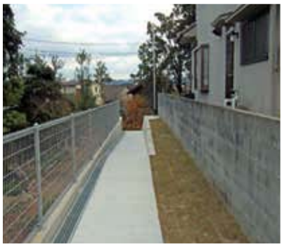
▲【宮崎地内】歩道新設
