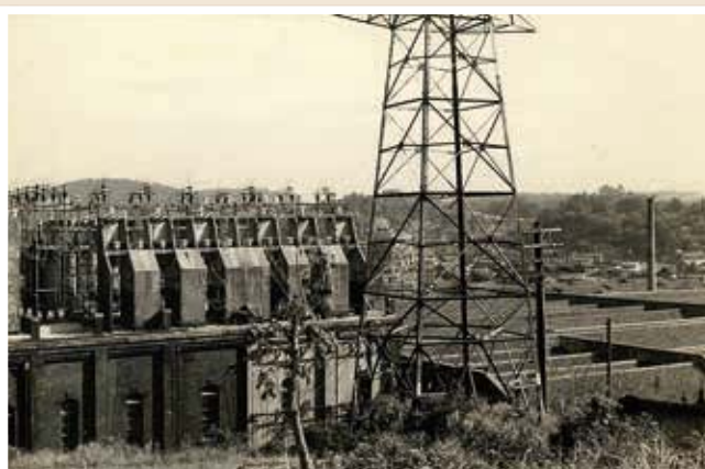
▲倉敷紡績早島工場と変電所
