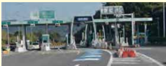
岡山 I C レーン増設前
