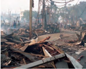
写真は神戸市提供-鷹取商店街周辺
