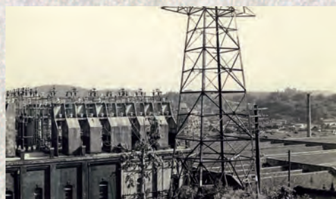
写真④ 倉敷紡績と変電所
