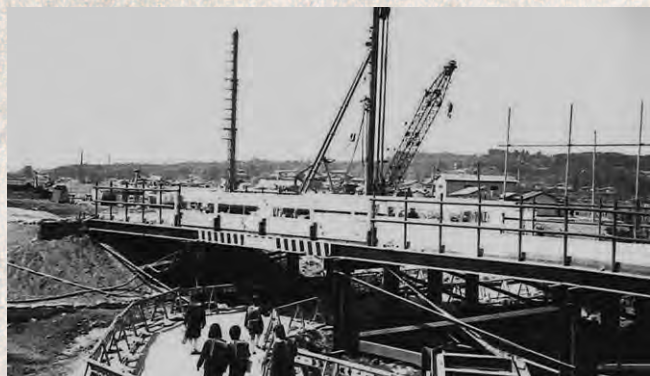
早島インターチェンジの工事(昭和61年)
