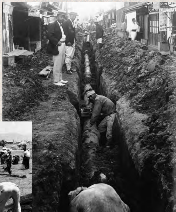
上水道工事(片田) 昭和5年
