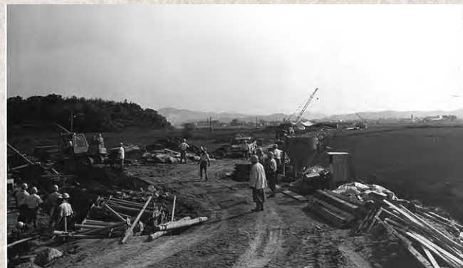
2号線バイパス工事(昭和44年)
