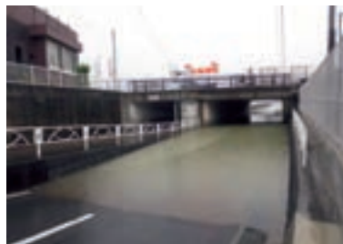
▲冠水した隧道（地下道）
