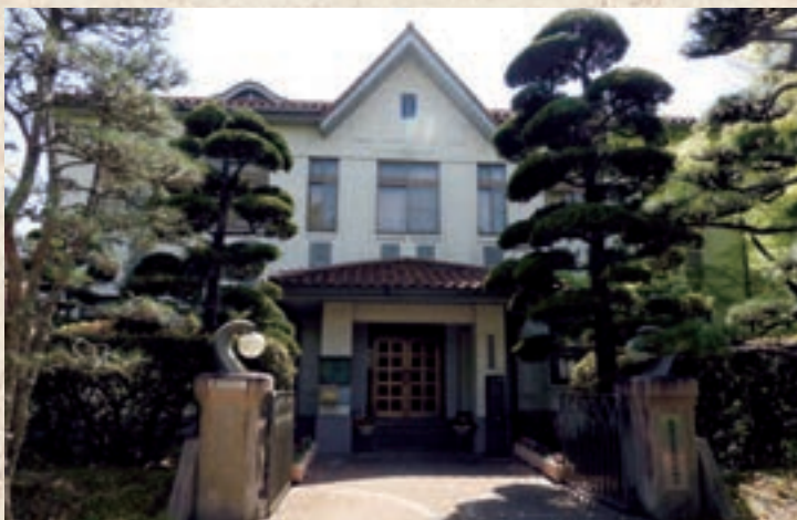
高梁川東西用水組合事務所（国指定重要文化財）大正15年建築
