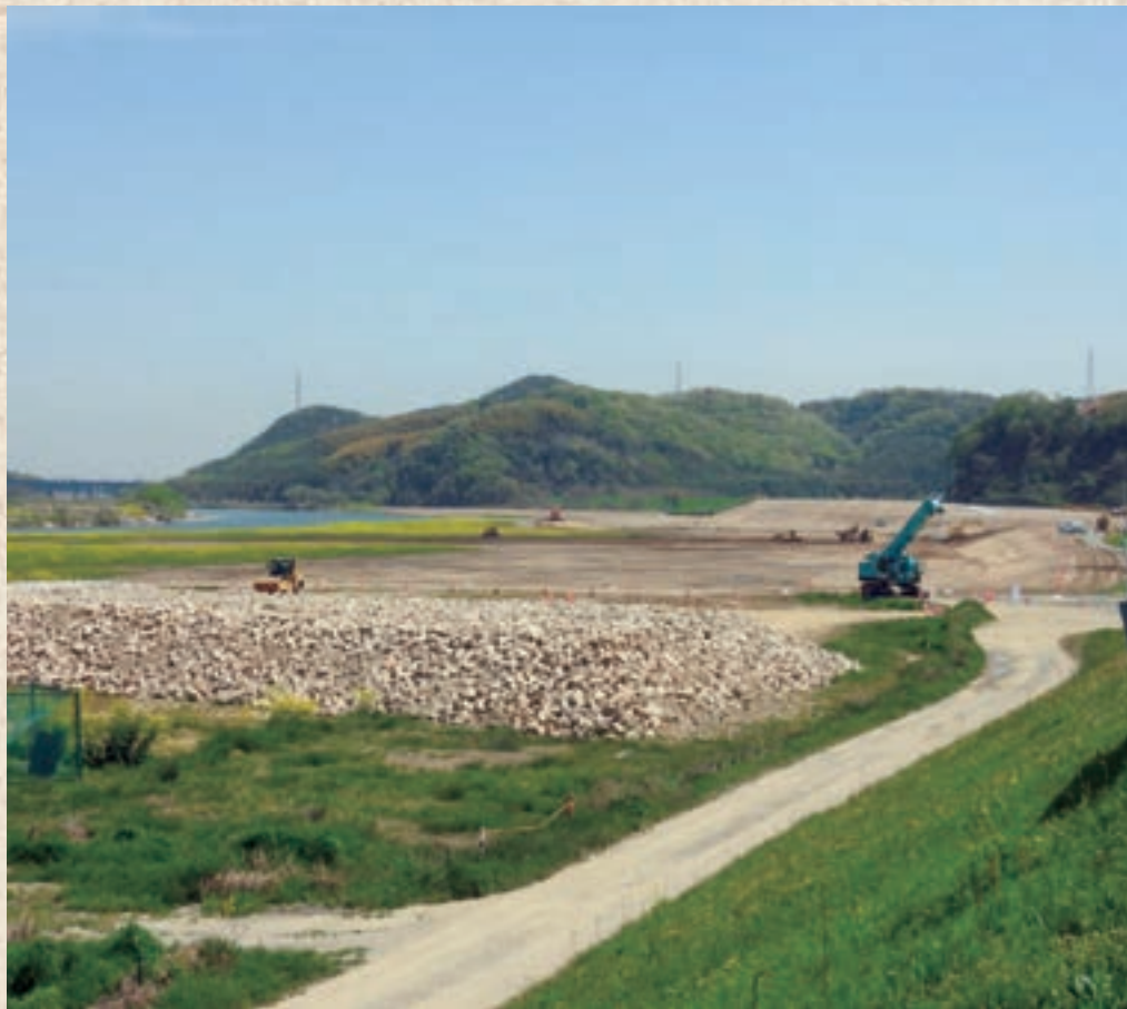
工事が進む小田川改修工事
