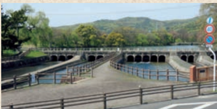
改修工事で新設された東西用水酒津樋門（国指定重要文化財） 右から倉敷、備前樋、南部、西部、西岸の各用水路。八力郷用水路は貯水池の北にある
