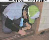
▲引き戸の修理
