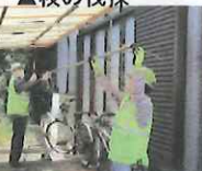
▲洗濯竿の設置
