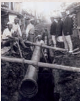
片田地内の水道管敷設工事 (昭和5年)
