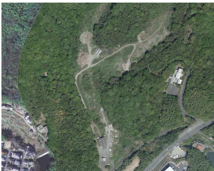
早島町一般廃棄物埋立処分地
