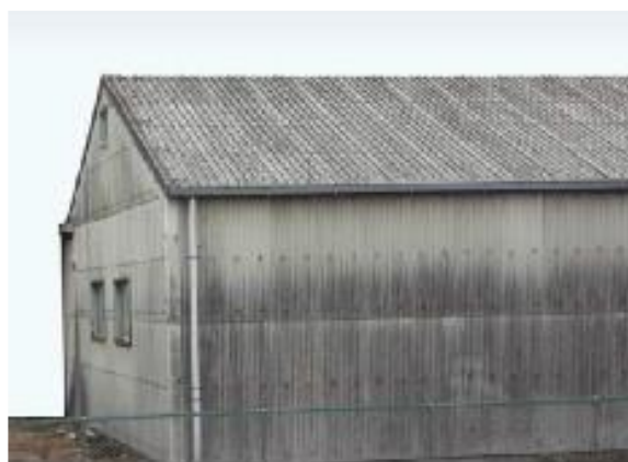
石綿含有スレート波板（屋根・外壁）
